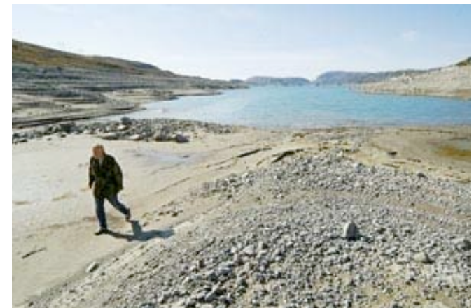
Langsæ kraftmagasin i Vinje høsten 2006
