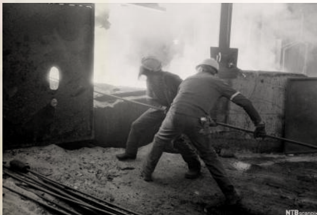
Arbeidere ved Sauda Smelteverk.
